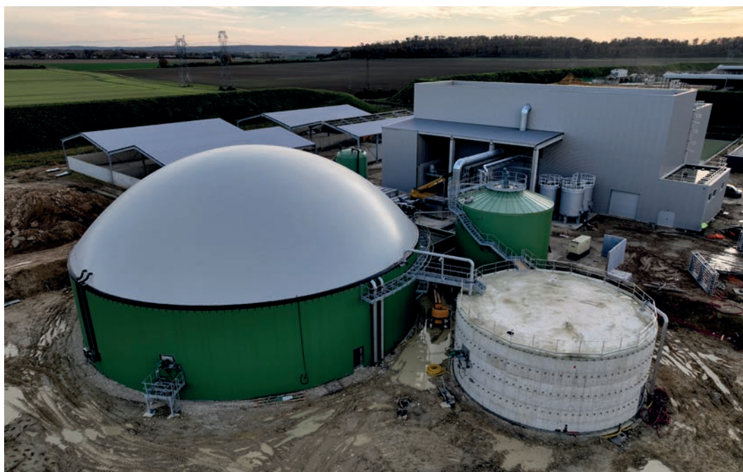
Chantier de construction du méthaniseur, novembre 2023
